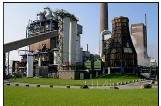
Kraftwerk auf dem Gelände des Lippewerks
